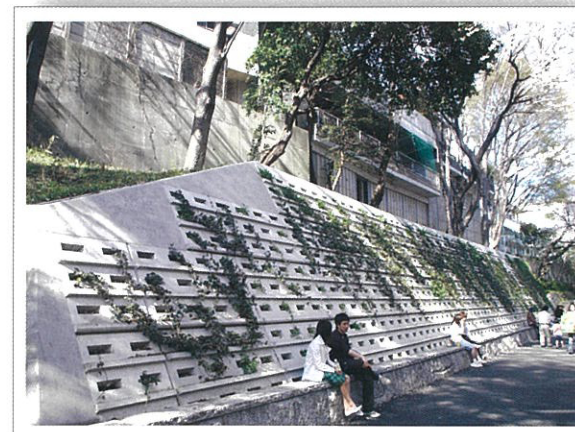
東京都内公園擁壁等整備工事 東京都文京区 施工期間:平成15年12月
