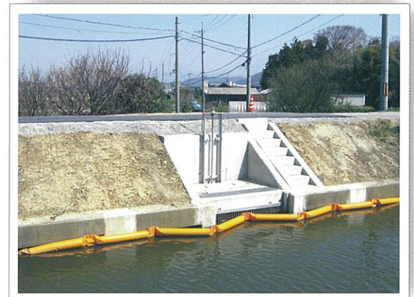
農業用水門基礎工事 滋賀県米原市 施工期間:平成22年12月
