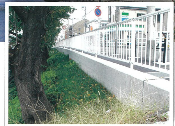
川崎市市道百合丘2号線 道路防護(擁壁)工事 神奈川県川崎市 施工期間:平成23年1月
